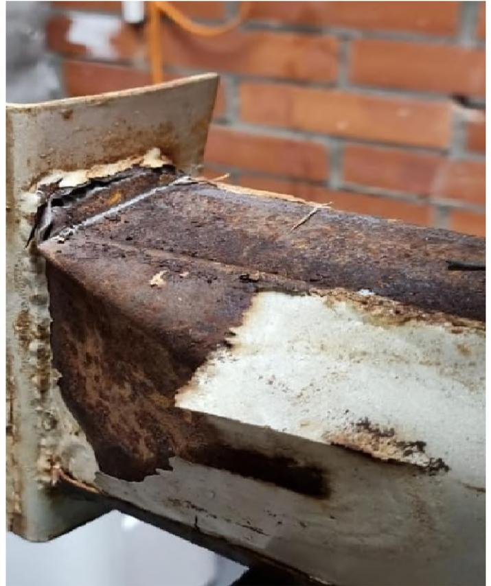
Дальнейшее исследование с помощью спектрометра показали не свойственные данной марки стали включения Р (фосфора), которое превышало максимальную норму в 8 раз.
