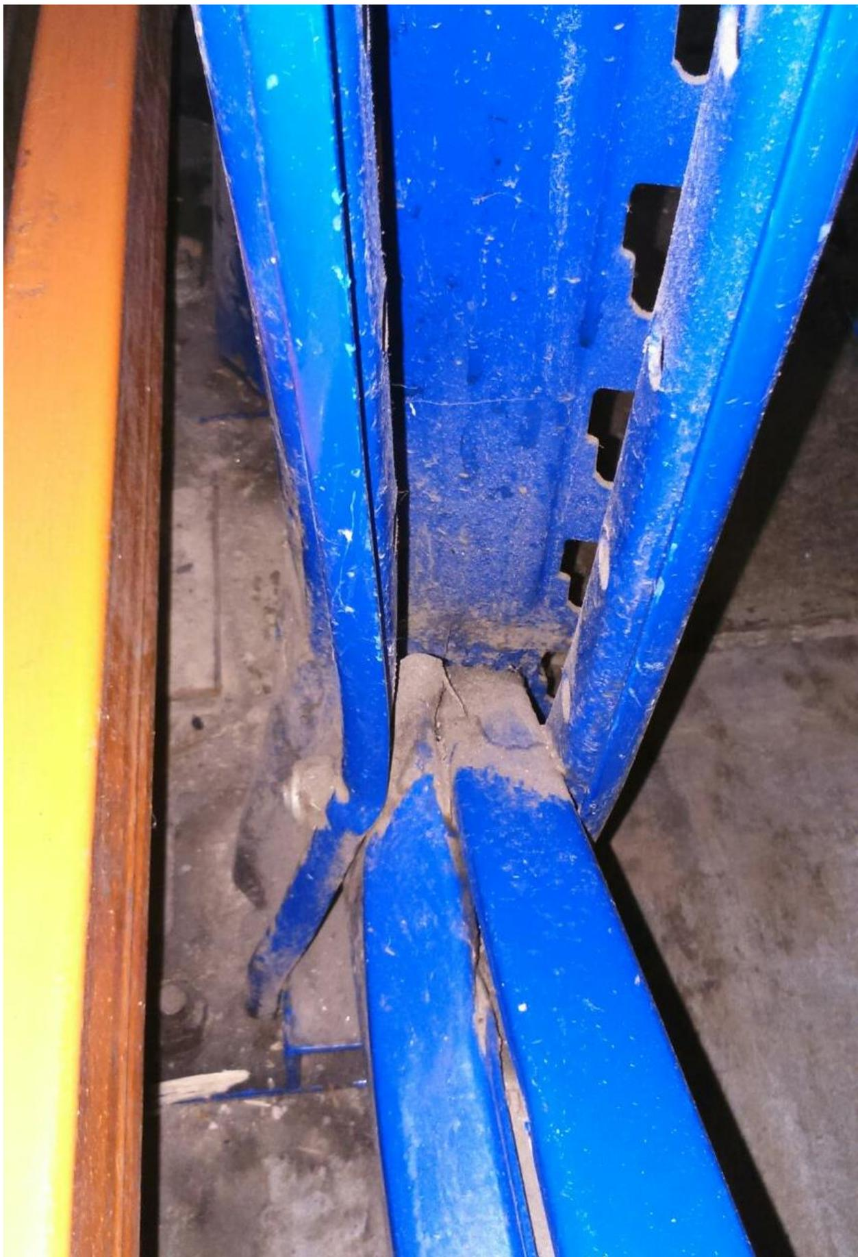
Разрыв металла вертикальной стойки
