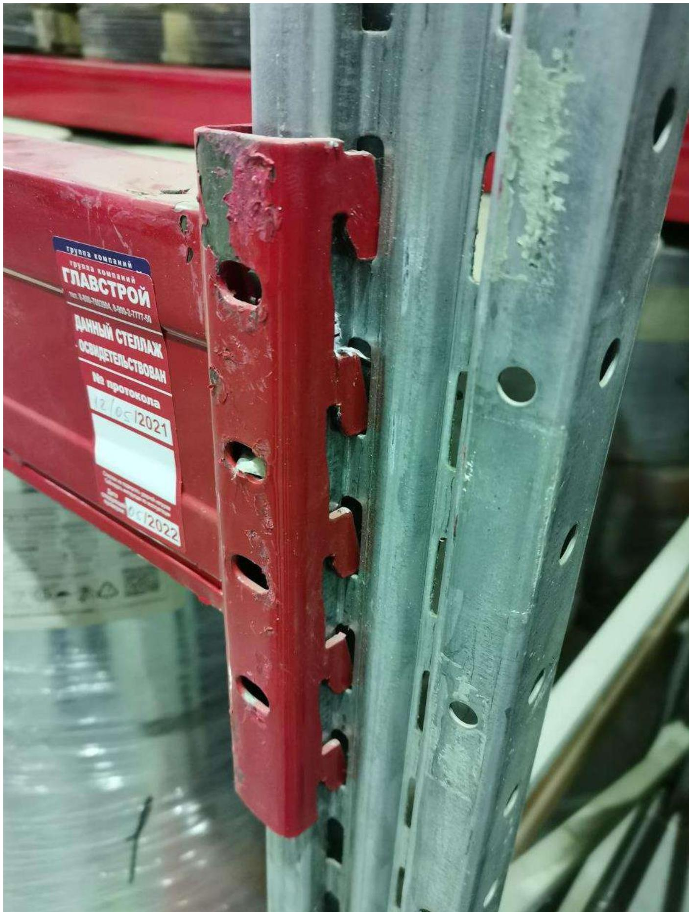
**Стойки смонтированы на деформационном шве (пол)**
