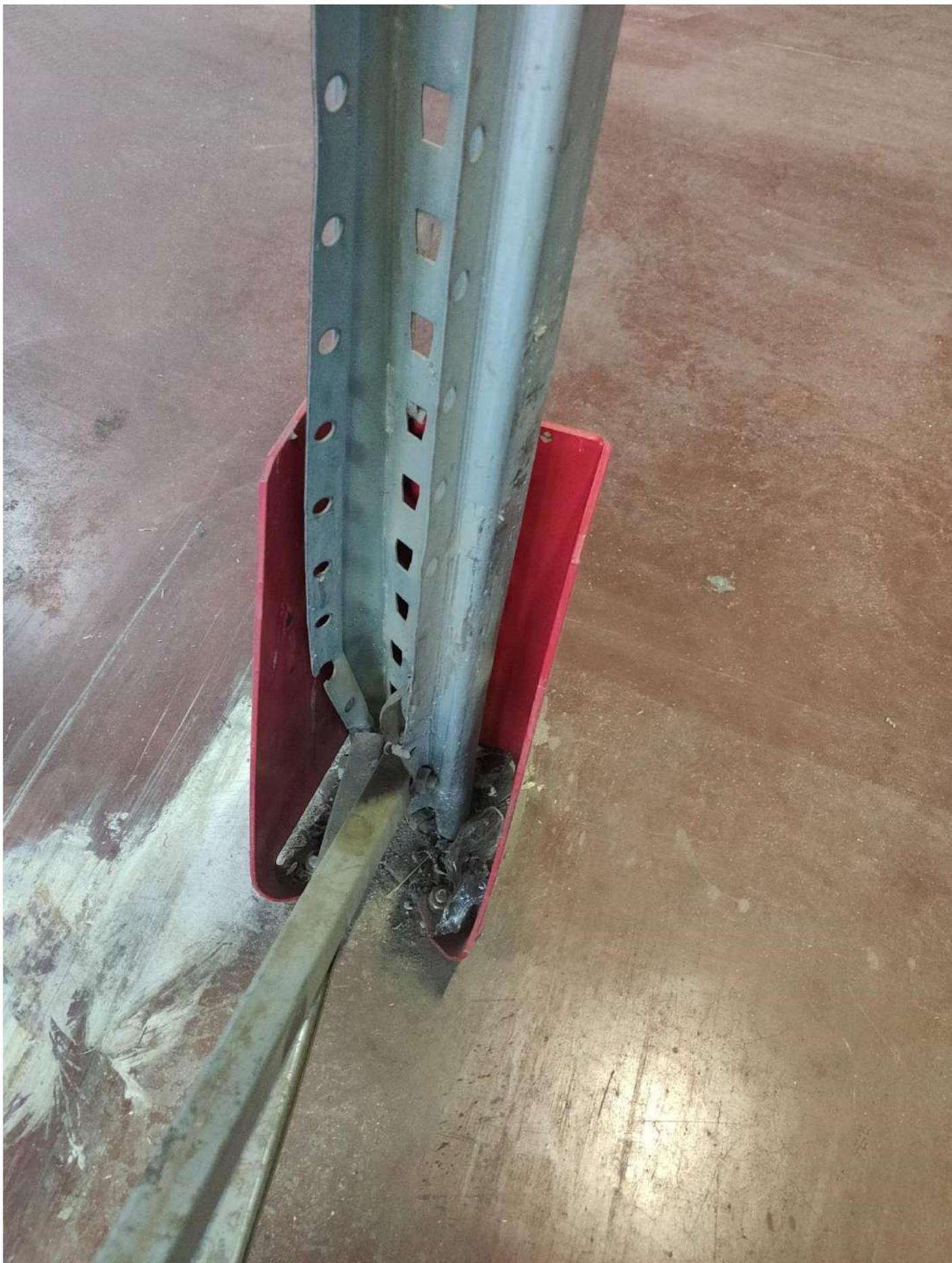
**Скручивание или вращение стойки – опасно!!! - эксплуатация запрещена!!!**
