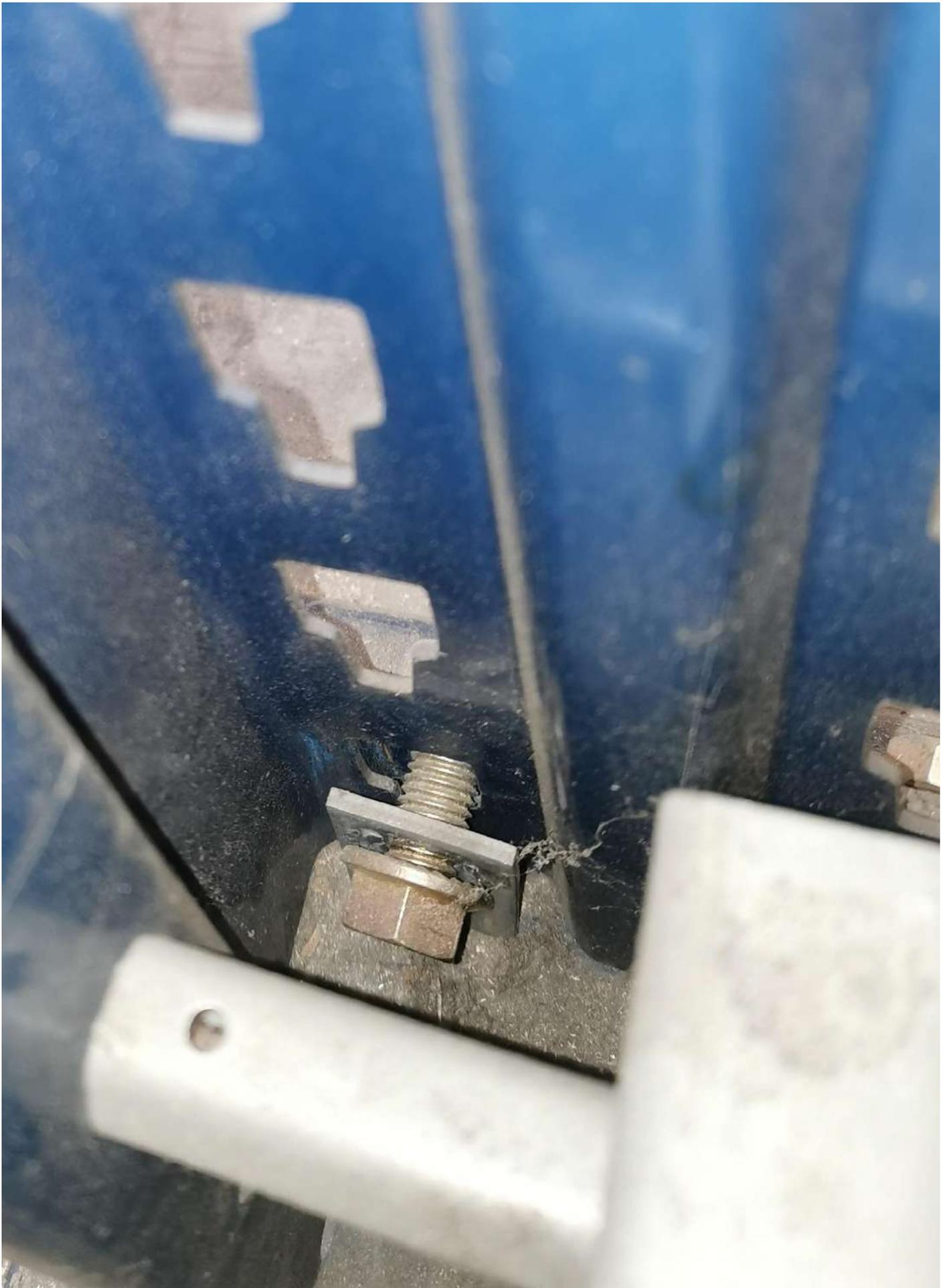
**«Рыхлый» пол под стеллажами, опасность его продавливания и опрокидывания**
