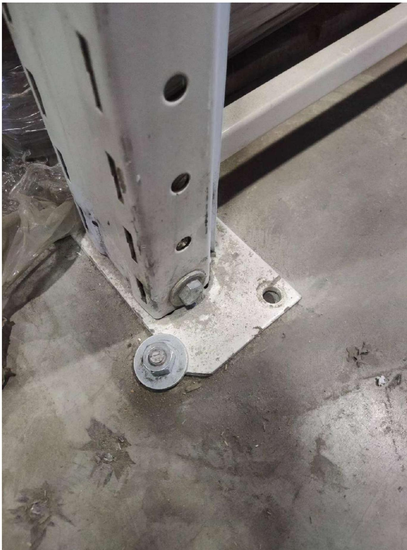
**Раскручивание болтовых соединений (частая причина резонанс от ШТ).**
