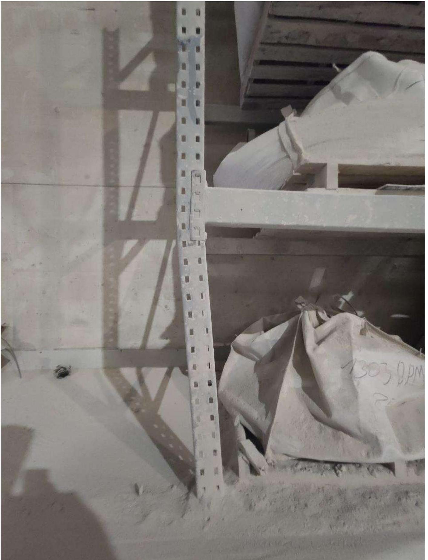
**Изменение конструкции – сварка не заводского исполнения**
